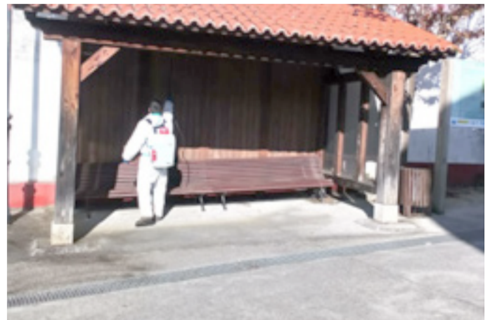
As marquesiñas foron obxecto de desinfeccións
