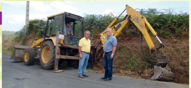
O Alcalde e o Concelleiro de Urbanismo supervisando as obras no tramo de Abrodos
