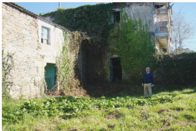
O Alcalde, no edificio de Souto obxecto deste proxecto.
