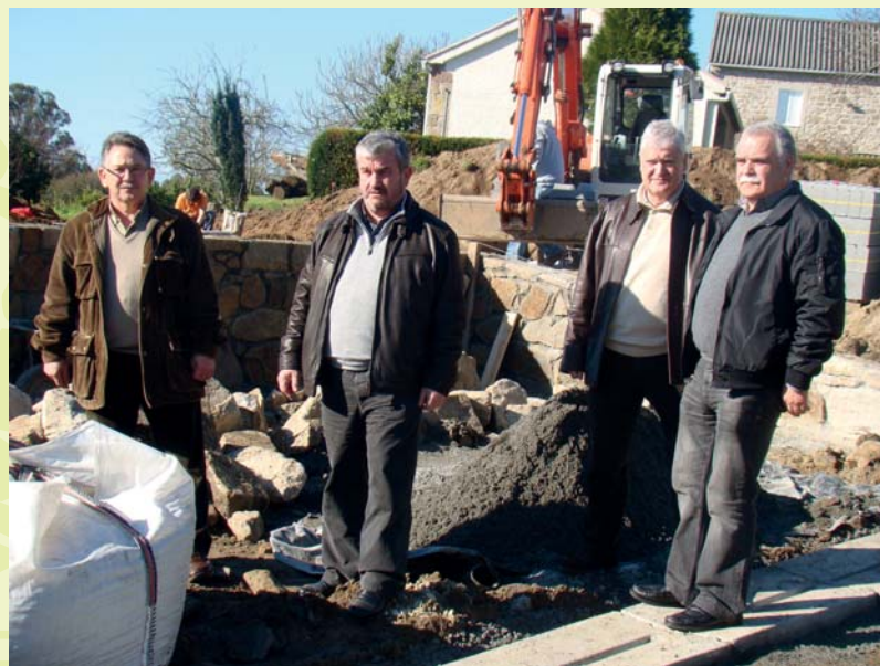
O Alcalde cos concelleiros e o técnico municipal, supervisando as obras da praza
